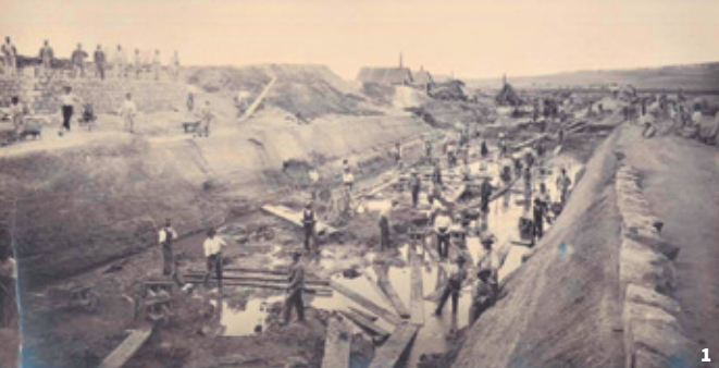
1. Construction du canal de l'Est
